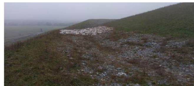
Piste et enrochement conservés
